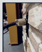
[Before] コネクタやケーブルの重みで斜めに傾いてしまう。
